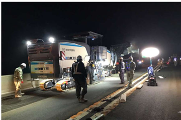
《傷んだ舗装撤去状況》
