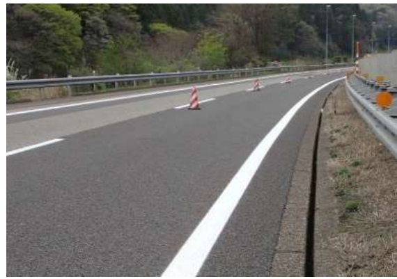
《路面標示工の施工》
