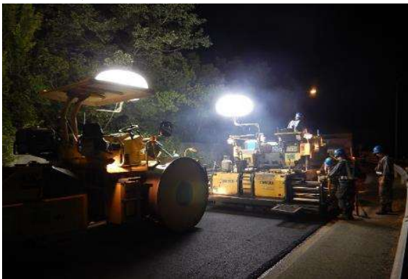
《路面損傷箇所の補修》
