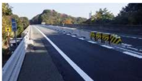
《センターブロック設置の例》
