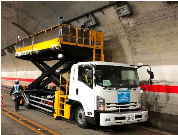
《設備点検・清掃》
