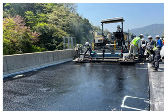
《床版防水工施工状況》
