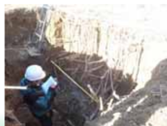
地下部掘削調査
