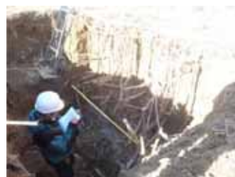
地下部掘削調査
