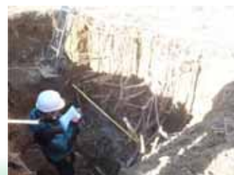
地下部掘削調査
