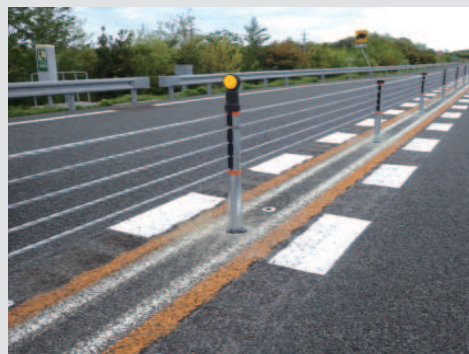
ワイヤロープ設置
