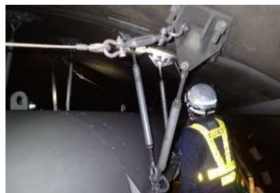
《トンネル換気設備の点検状況》
