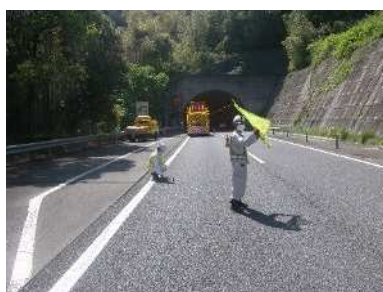
《路面の点検状況》
