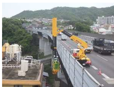
《遮音壁の点検状況》
