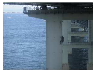
《橋梁の点検状況》
