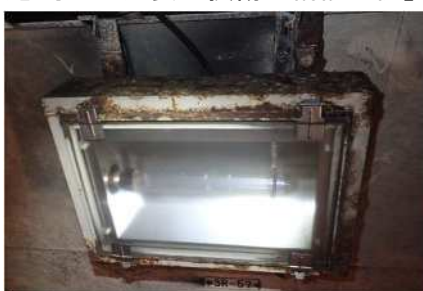
《トンネル照明の緊急補修（補修前）》
