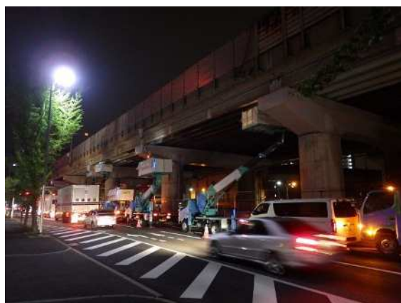
《コンクリート片剥落対策（橋梁）》
