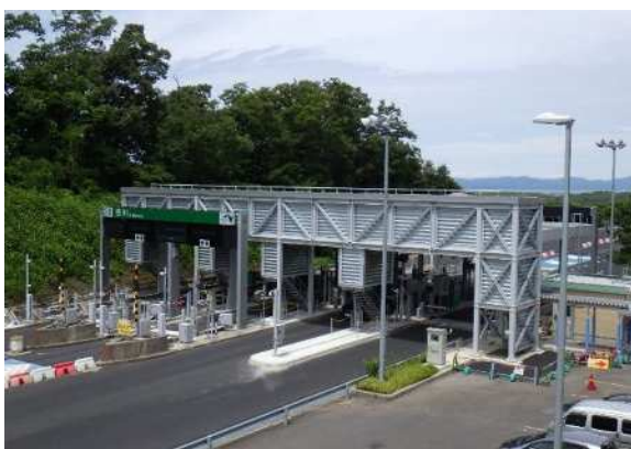
《 料金所上屋通路 》
