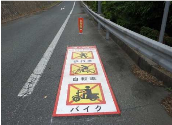
《ポストコンクリートカバー及び路面標示による対策》
