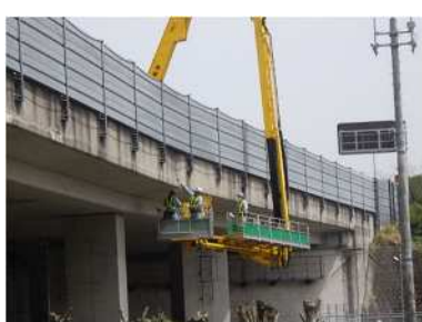
《橋梁の点検状況》
