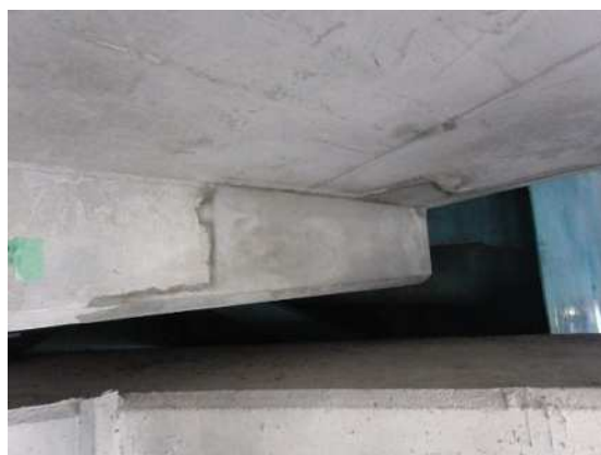
《橋梁桁端部補修（橋梁）》
