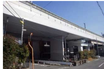
《橋梁上部工はく落対策（補修後）》
