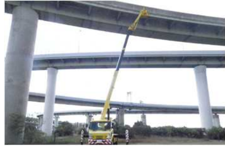
《橋梁下面の点検状況》
