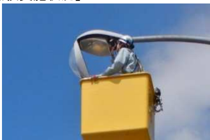
《道路照明の点検状況》
