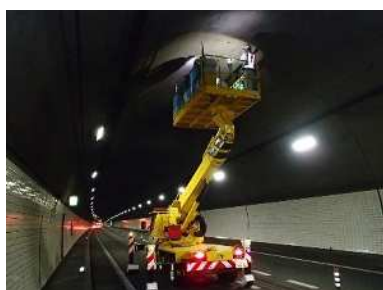
《トンネルの点検状況》
