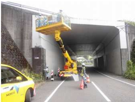
《ボックスカルバートの点検状況》
