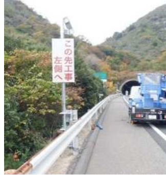
《工事規制予告標識自動反転装置（E-標識ローテーター）》
