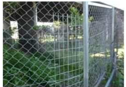
《立入防止柵の補修》
