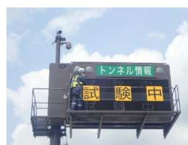
《情報板の点検状況》
