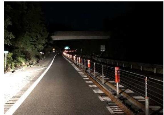
《ワイヤロープ区間における視認性向上対策》
