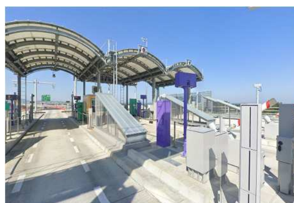
《 料金所地下通路 》
