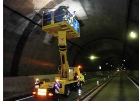
《トンネル覆工の点検状況》
