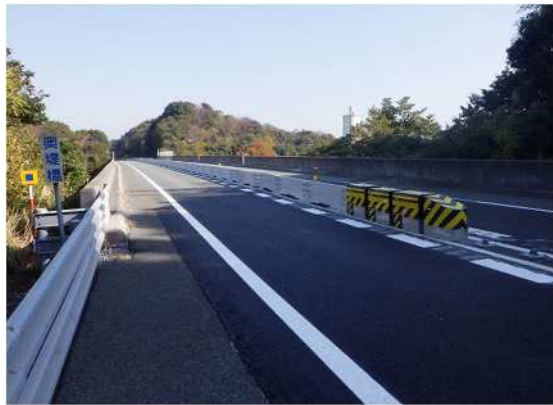
《区画柵（センターブロック）の試行設置》
