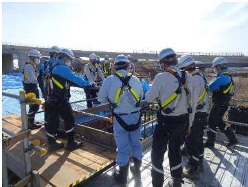
《安全パトロール実施状況》
