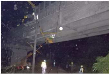
《橋梁下面の点検状況（鉄道交差）》
