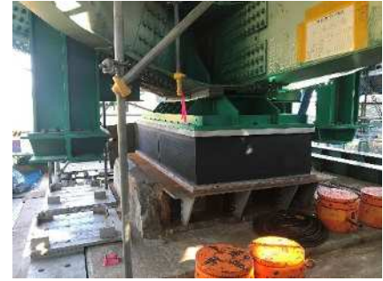
「補強後（支承取替）」
