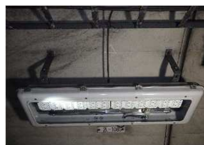
《トンネル照明の緊急補修（補修後）》
