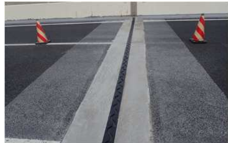
《伸縮装置の損傷（補修後）》
