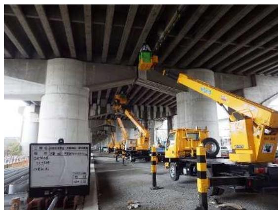
《コンクリート片剥落対策（橋梁）》
