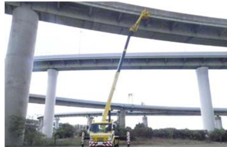
《橋梁下面の点検状況》
