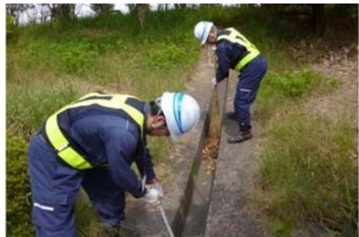
《不動産管理点検時の排水溝清掃》
