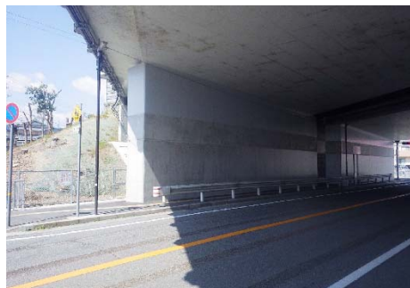
《ロッキング橋脚補強後》
