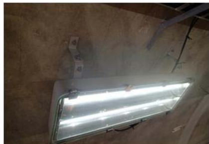
《トンネル照明の緊急補修(補修後)》
