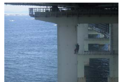
《橋梁の点検状況》
