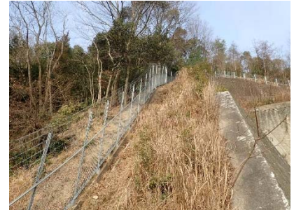
《動物侵入防止対策》
