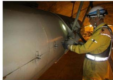
《トンネル換気設備の点検状況》
