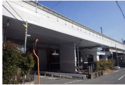
《橋梁上部工はく落対策(補修後)》
