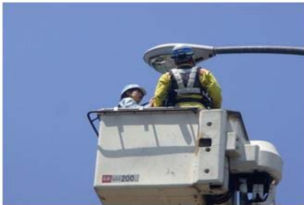
《道路照明の点検状況》
