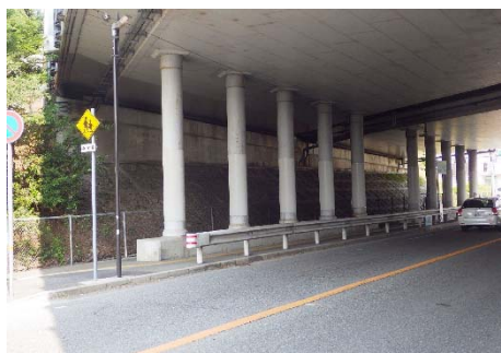
《ロッキング橋脚補強前》
