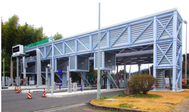
《 料金所上屋通路 》
