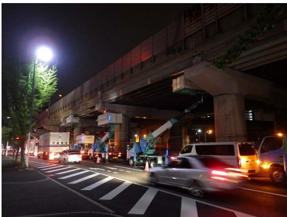
《コンクリート片剥落対策(橋梁)》
