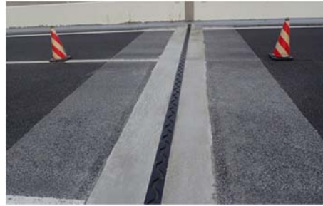
《伸縮装置の損傷(補修後)》
