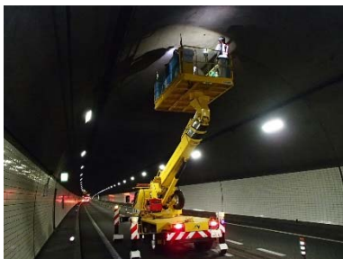
《トンネルの点検状況》
