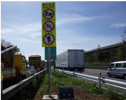
《看板による立入防止対策》
