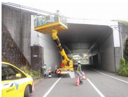
《ボックスカルバートの点検状況》
