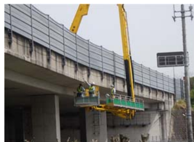
《橋梁の点検状況》
