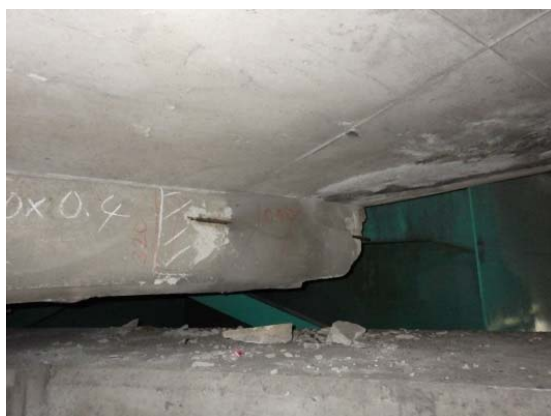
《コンクリート片剥落対策(橋梁)》
