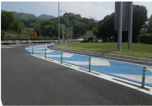
《ラバーポール増設による対策強化》
