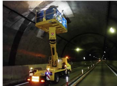
《トンネル覆工の点検状況》
