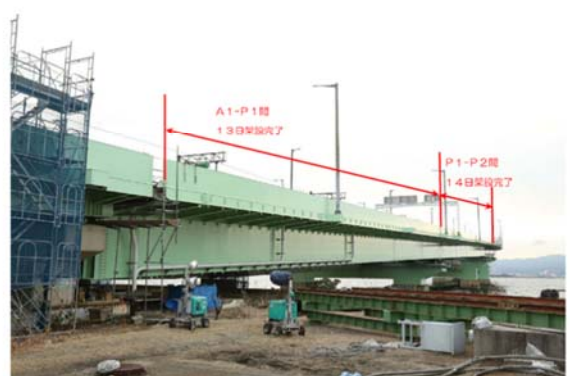
○架設完了状況
