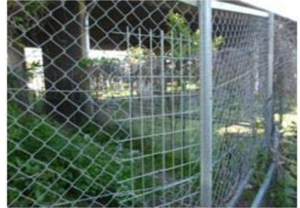
《立入防止柵の補修》
