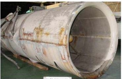
《トンネルジェットファン(補修前)》
