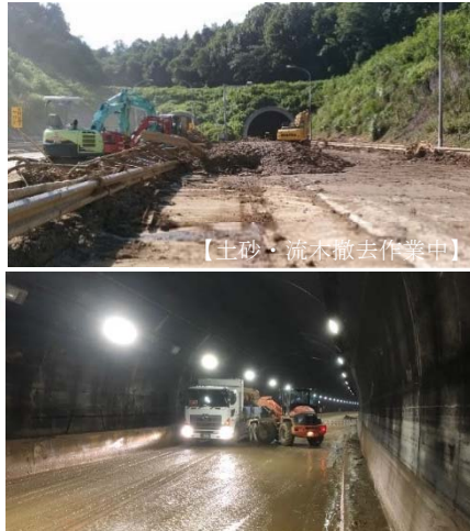
応急復旧工事
