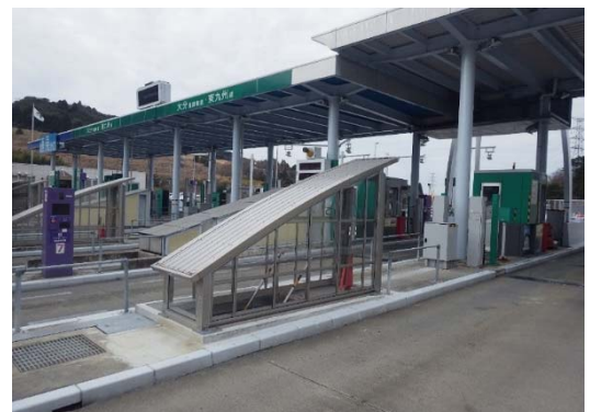
《 料金所地下通路 》
