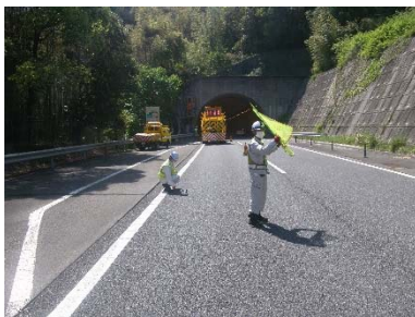
《路面の点検状況》
