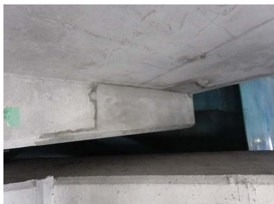
《橋梁桁端部補修(橋梁)》
