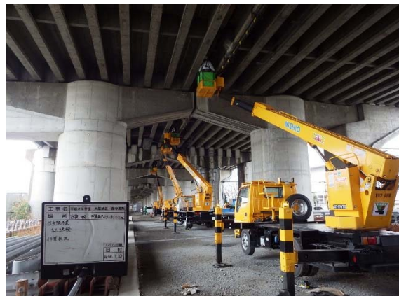
《コンクリート片剥落対策(橋梁)》
