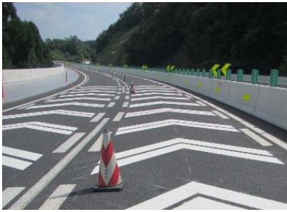
《高機能舗装及び導流レーンマーク》
