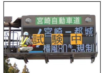
《情報板の点検状況》
