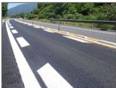
《導流レーンマークによる対策》
