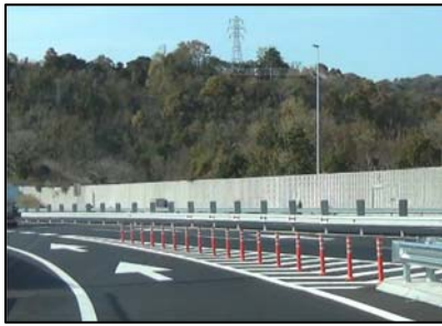
《ラバーポール＋大型矢印路面標示》
