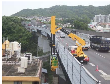
《遮音壁の点検状況》
