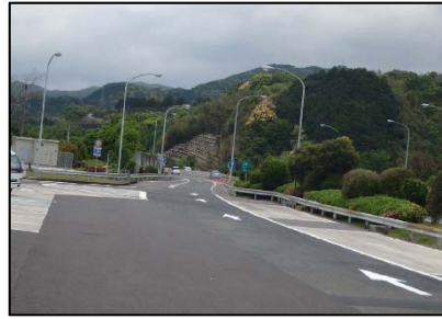
《休憩施設スルーレーンに矢印路面標示》
