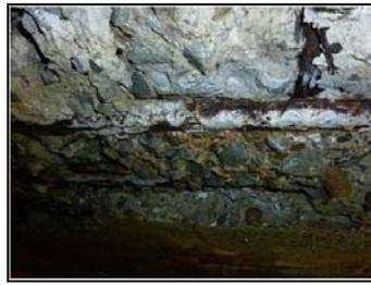
コンクリートの剥離、鉄筋腐食
