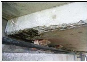
コンクリートの剥離、鉄筋腐食
