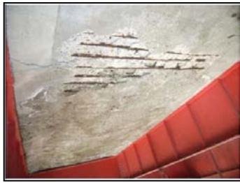
コンクリートの剥離、鉄筋腐食
