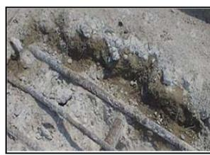
コンクリートの土砂化
