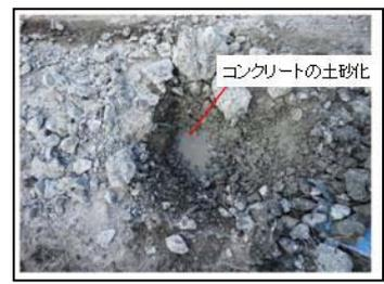
コンクリートの土砂化
