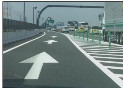
《大型矢印路面標示及びポストコーンの設置》
