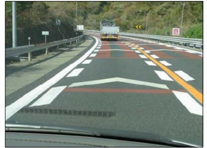
《速度抑制路面標示の設置》
