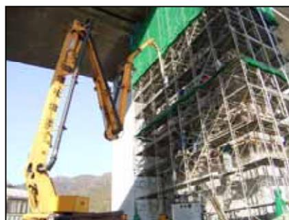
橋脚耐震補強工事の状況
