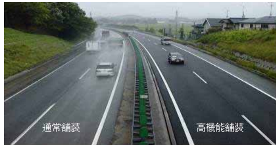
通常舗装と高機能舗装との比較例
