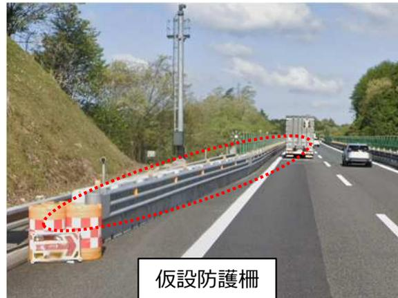
仮設防護柵の設置・撤去は、集中工事規制と同じタイミングで実施することにより全体規制回数を削減
