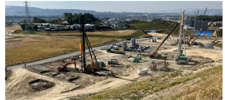
地盤改良施工状況
