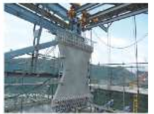
バタフライウェブの架設
