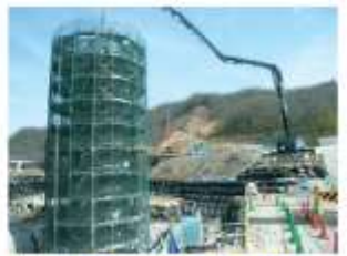
橋脚中詰コンクリートの打設
