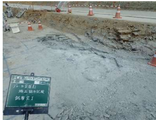
亀裂が無く、ブレイカー打撃時に先端が表面を滑ってしまい、表面しか破碎できない
