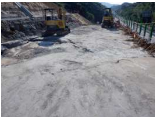
亀裂の少ない硬岩が面的に露出
