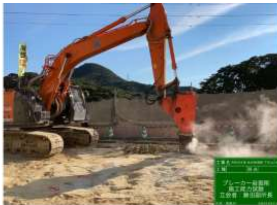
亀裂が無く、ブレイカー打撃時に先端が表面を滑ってしまい、表面しか破碎できない
