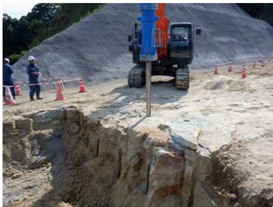
割岩工法(ビッカー)施工状況
