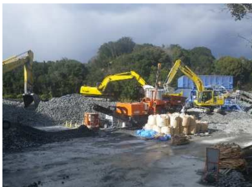
不溶化処理状況
