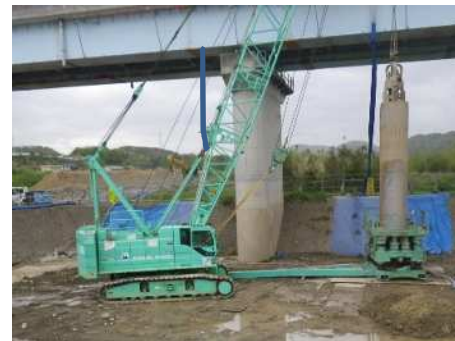
《変更施工状況》 全周回転オールケーシング工法
