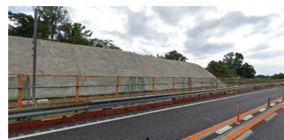
4車線化事業設置状況
