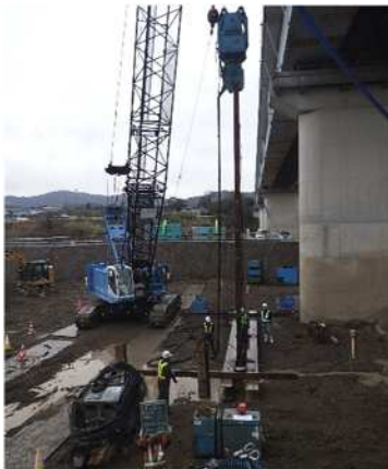
《当初施工状況》 ガンパイル工法
