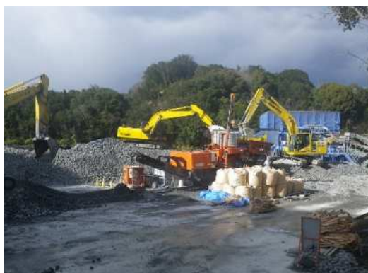
不溶化処理状況
