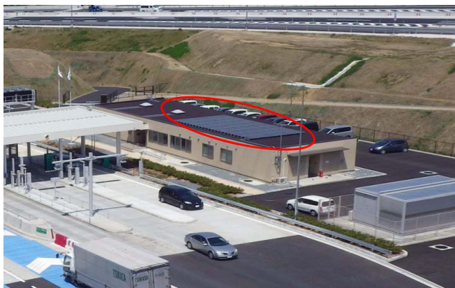
太陽光発電システム(沓掛IC)
