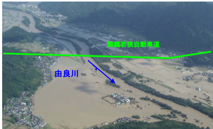
由良川橋の氾濫（平成25年の台風18号）
