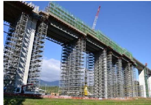
固定支保工による上部工施工
