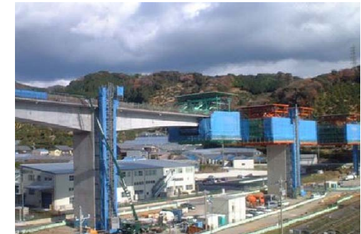
移動支保工による上部工施工
