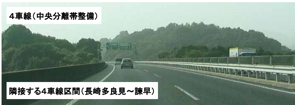
▲2車線区間と4車線区間
