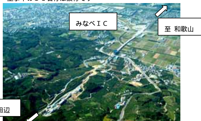
阪和自動車道みなべ～田辺の現況（平成18年12月撮影）
