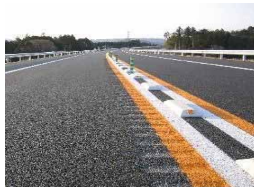
（暫定2車線区間の凹凸型路面標示）
