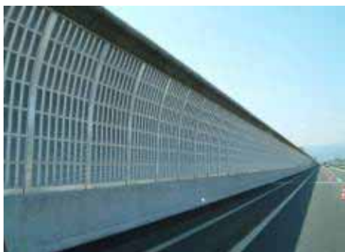
(遮音壁設置の実施例)
