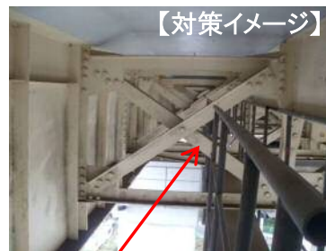
桁補強 (対傾構の増設など)
