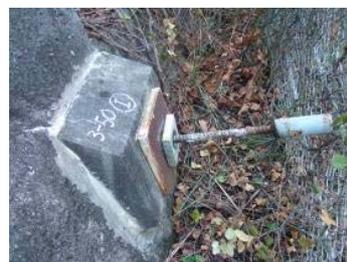
図 4.5.14 旧タイプグラウンドアンカーの劣化
