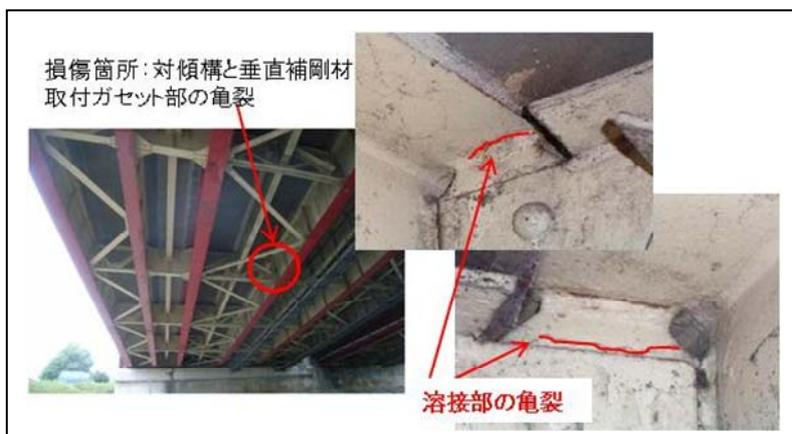
図 4. 6. 11 鋼桁の変状事例
