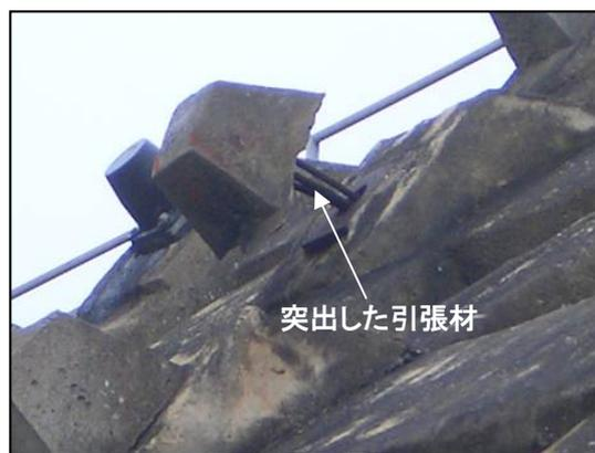
旧タイプアンカーは、防食性能が低く、腐食により破断した事例。
