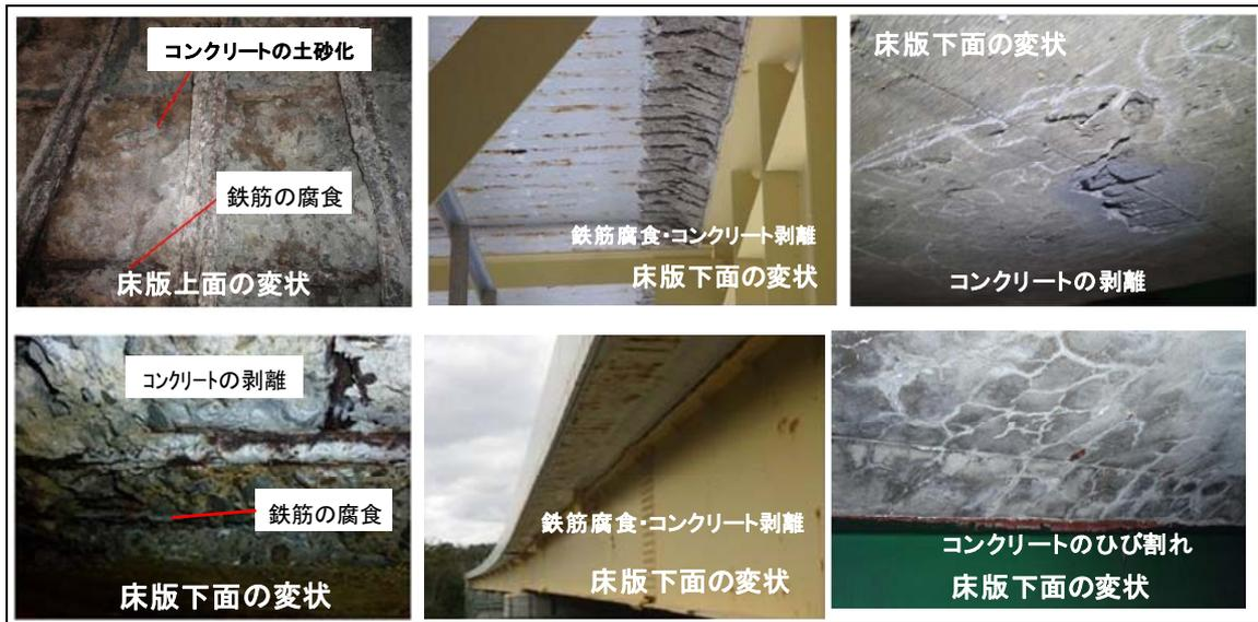
図 4. 6. 3 鉄筋コンクリート床版の変状事例
