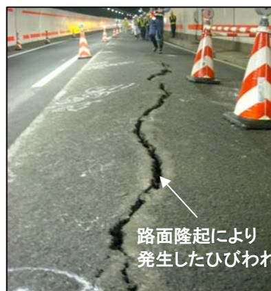
周辺地山の劣化により、トンネルに圧力が加わり、舗装路面が盛り上がることでひびわれが入った事例。
