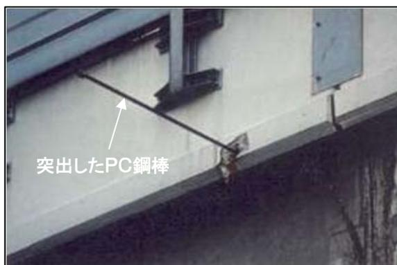
床版からの雨水等の侵入や何らかの原因でPC鋼材が腐食・破断した事例。
