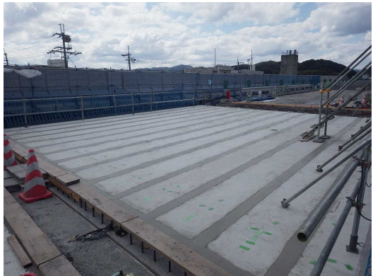
桁架設完了状況
