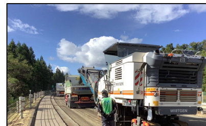
舗装開削・既設路盤撤去 ➢路面切削機により既設舗装を撤去
