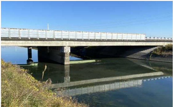
名神 川口高架橋の外観
