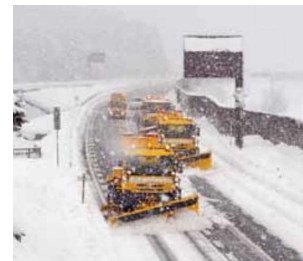
除雪作業状況
