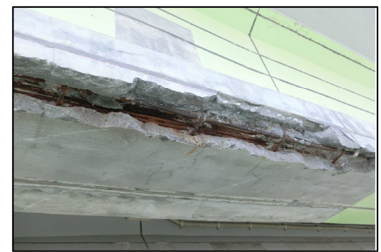
(桁の架替え等: E84西湘バイパス 滄浪橋)
