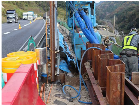
供用中本線近接箇所における鋼矢板打設事例(E20中央自動車道 小仏地区渋滞対策事業)
