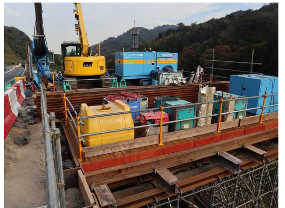
供用中本線近接箇所における鋼矢板打設事例(E20中央自動車道 小仏地区渋滞対策事業)
