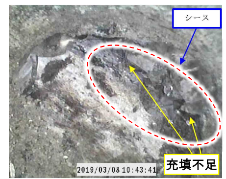
(充填材の再注入: E1東名高速道路 川音川橋)
