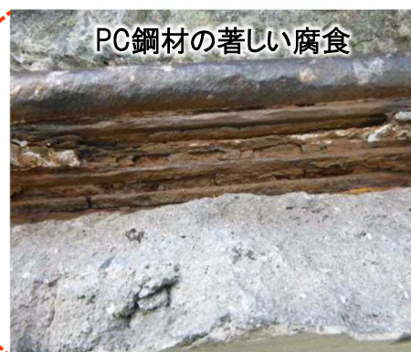
PC鋼材の変状状況
