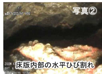
(小径削孔調査による水平ひび割れの確認)
