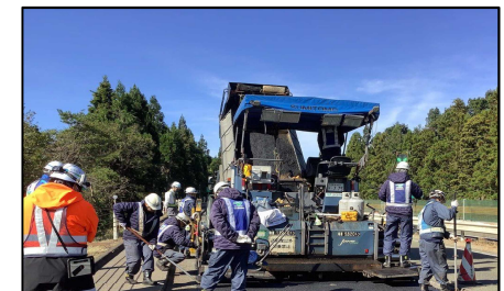
高耐久路盤舗設 ➢アスファルトフィニッシャーにより敷き均し
