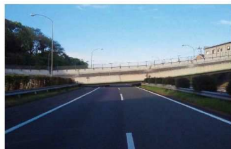
跨道橋の落橋
