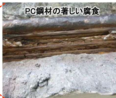
PC鋼材の変状状況
