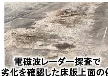
(床版内部の水平ひび割れ)
