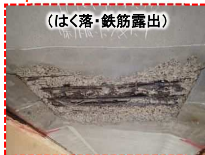
床版下面の損傷状況①
