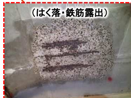
床版下面の損傷状況②
