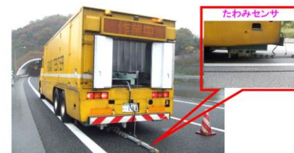
FWD調査状況
