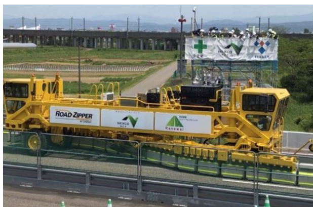
報道関係者向けに床版取替 (ロードジッパーによる規制設置)の現場を公開。 (E8北陸自動車道での更新工事、中之島見附IC～三糸燕IC間、R3(2021)年度)
