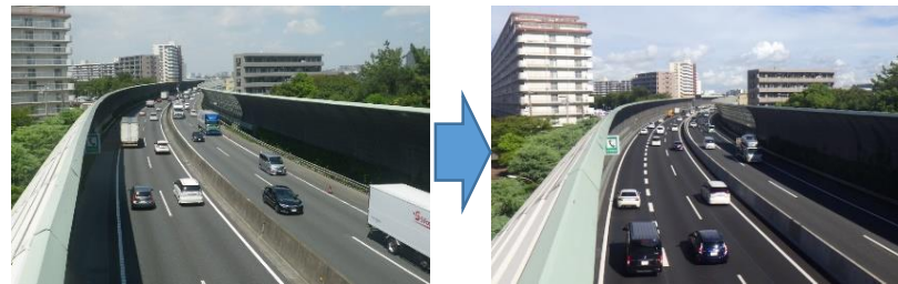
付加車線の設置 (E14京葉道路(上) 武石IC→船橋IC)
