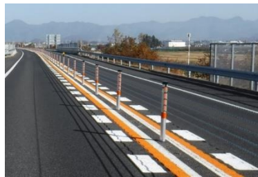
暫定2車線区間の安全対策の推進 (ワイヤロープの設置)
