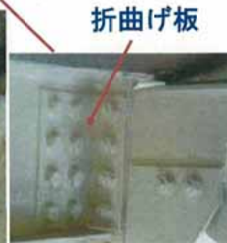
19年後 : ストップホール・折曲げ板取付け
