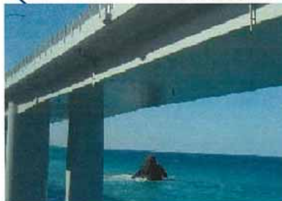
15年後 : コンクリート塗装
