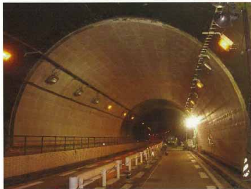
内面補強対策工による対策状況
