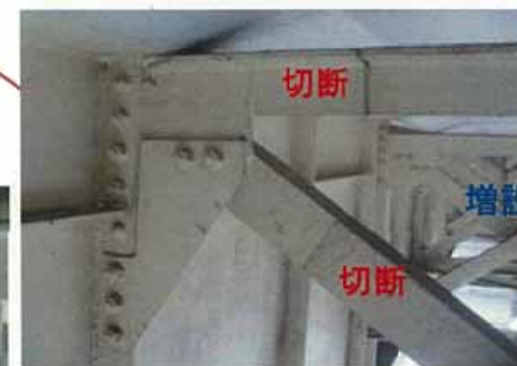
21~25年後 : 対傾構増設と既設対傾構切断
