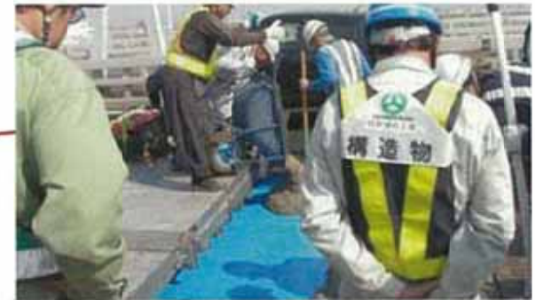
20年後 : SFRC施工(一部)
