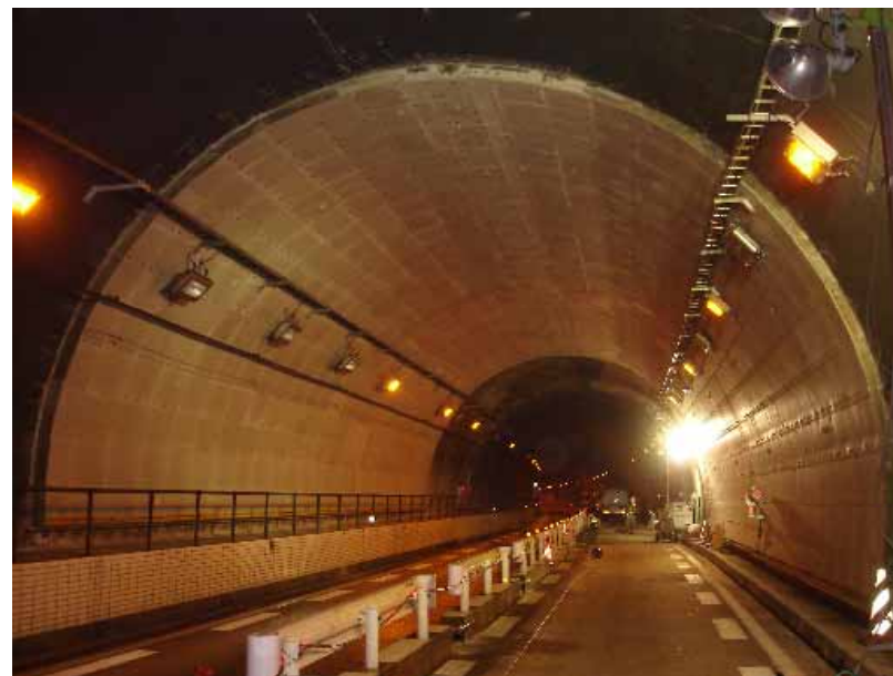
内面補強対策工による対策状況
