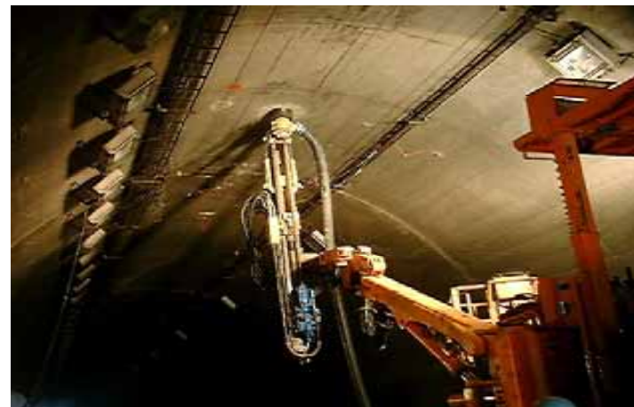
覆工背面空洞注入対策状況
