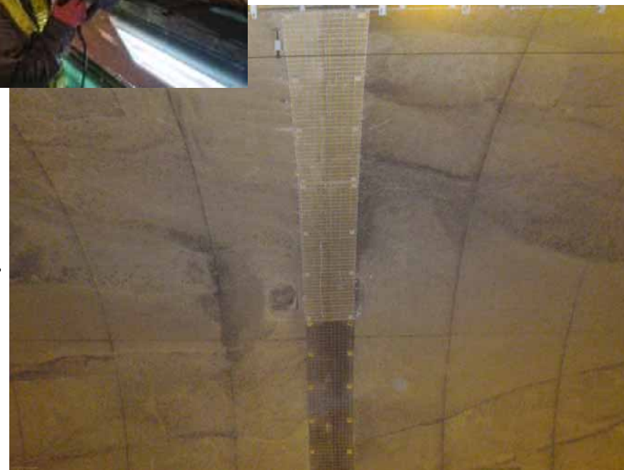
対策状況(目地部はく落対策)
