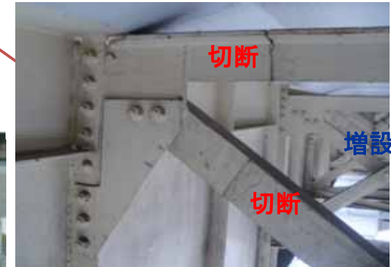
21~25年後 : 対傾構増設と既設対傾構切断
