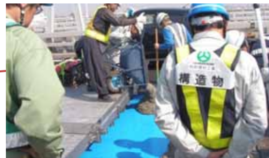
20年後 : SFRC施工(一部)
