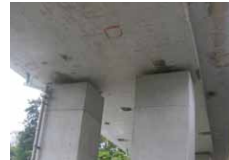
34年後 : 架替後のプレテンPCホロー桁
