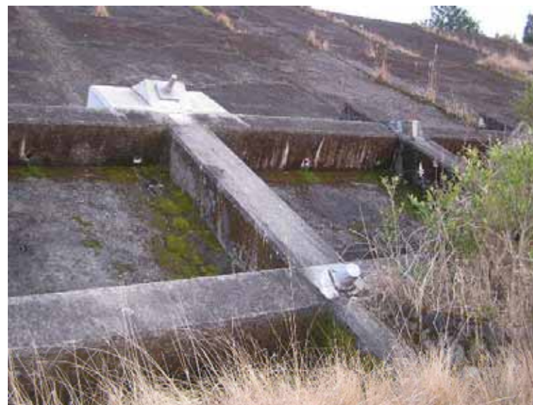
アンカー増打ちなど補強アンカー
