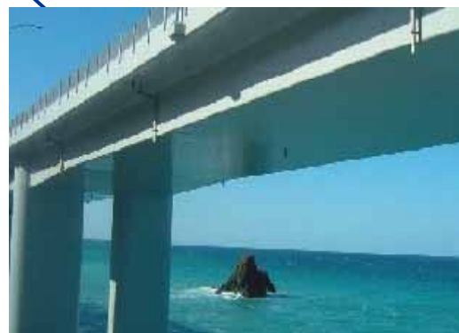
15年後 : コンクリート塗装
