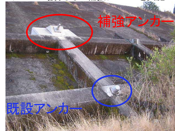
アンカー増打ちなど補強アンカーを実施
