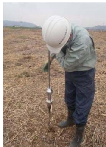
写真 3.3.4.2 簡易動的コーン貫入試験
