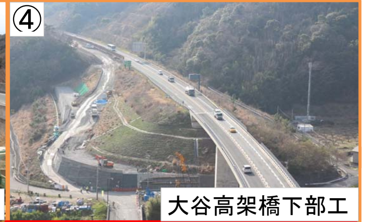
③ 古田橋下部工
