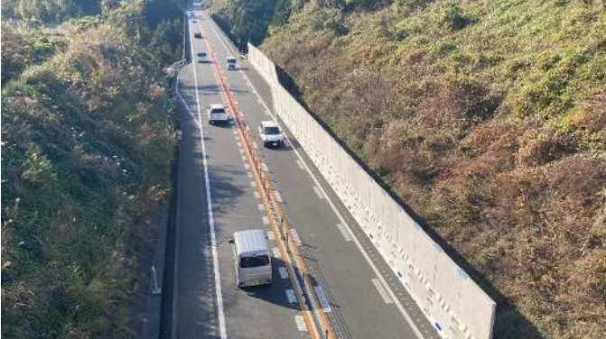
仮設防護柵 (新谷工事) の施工状況
