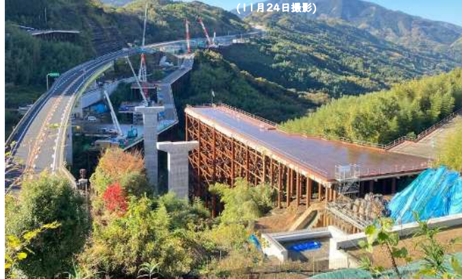
上灘川橋 (鋼上部工) の施工状況
