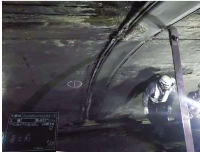
【漏水防止樋取替】
