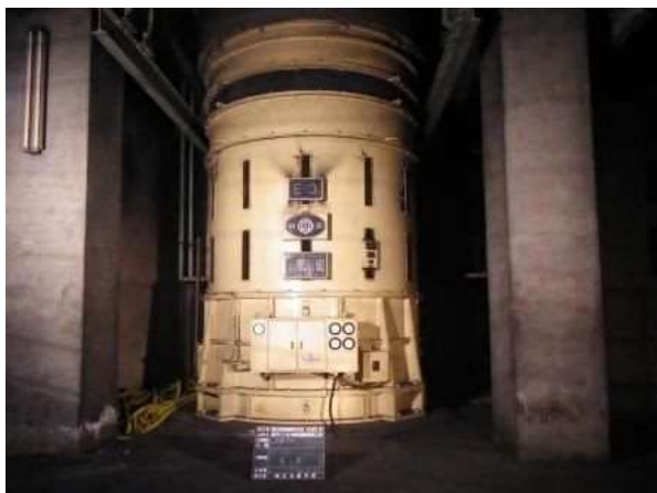
【換気設備更新】
