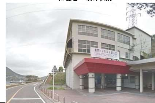
人道トンネル入口(門司側) (人道エレベーター、換気施設、排水施設)
