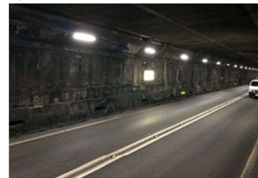
対面2車線の状況
