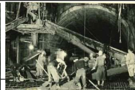
昭和30年頃 門司立坑付近 床版コンクリート打設
