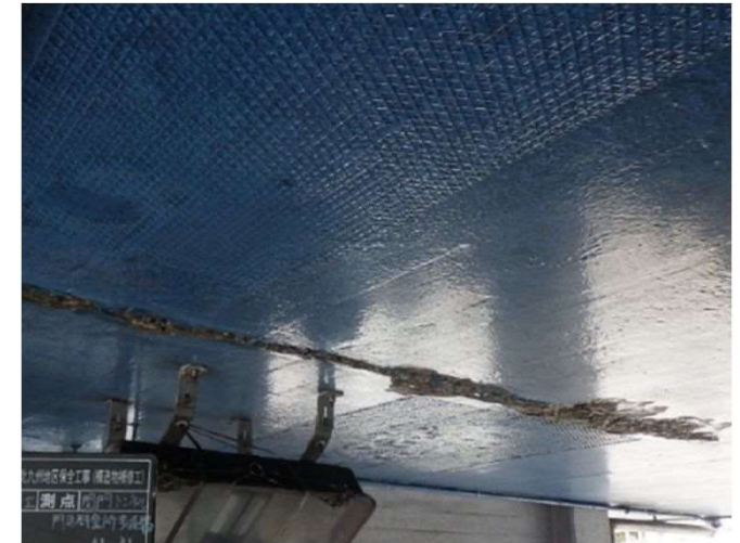
【料金所上屋構造物補修】
