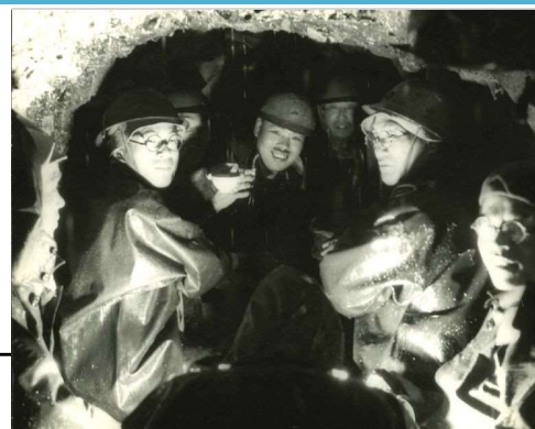
昭和14年4月 調査用トンネル貫通※
