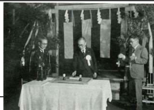
昭和17年5月 本トンネル導坑貫通※
