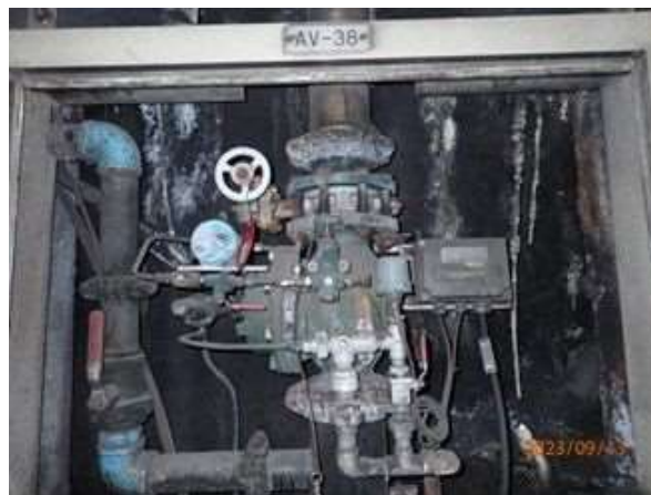
【非常用設備更新】
