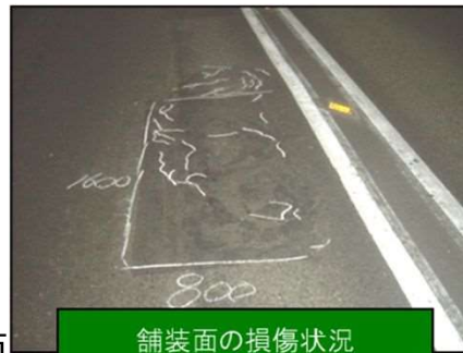
※リフレッシュ工事前
