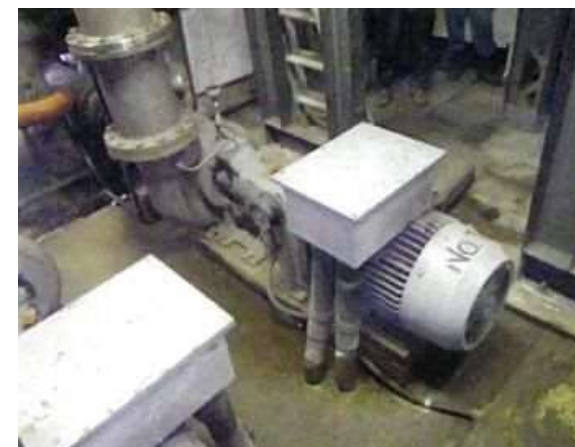
【排水ポンプ更新】
