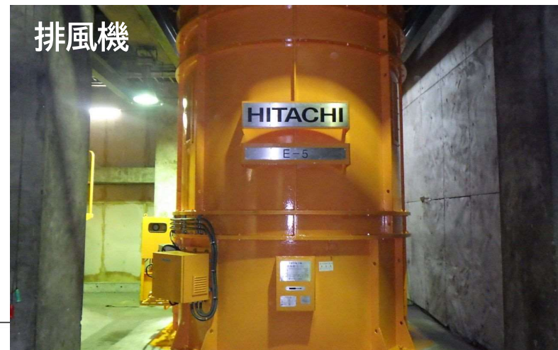
トンネル内の換気設備
