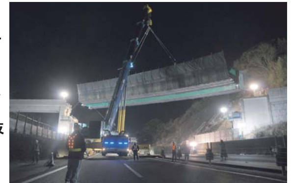
夜間工事の様子
