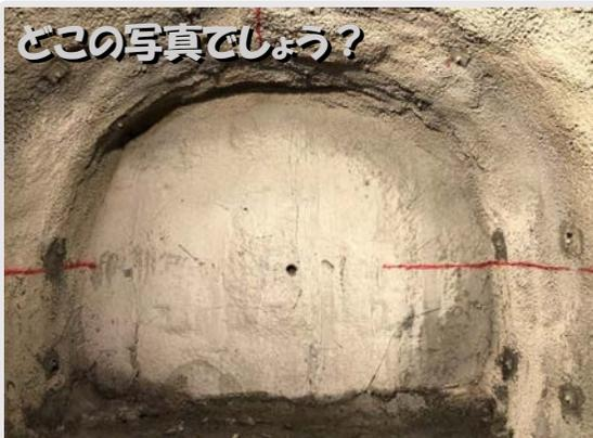
A. 弓張トンネルのⅠ期線（供用中トンネル）とⅡ期線（施工中トンネル）をつなぐ避難連絡坑から見たトンネル裏側。下の写真の赤枠内の裏側の状況です。
