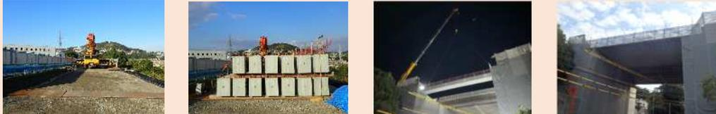
夜間通行止め期間中の令和2年11月4日～12日の平日6夜間にわたり、桁架設を行いました。桁架設自体は2夜間で行い、1本の桁架設に約20分要しながら、合計13本の桁を架設しました。今後は壁高欄、伸縮装置等の設置を行います。
