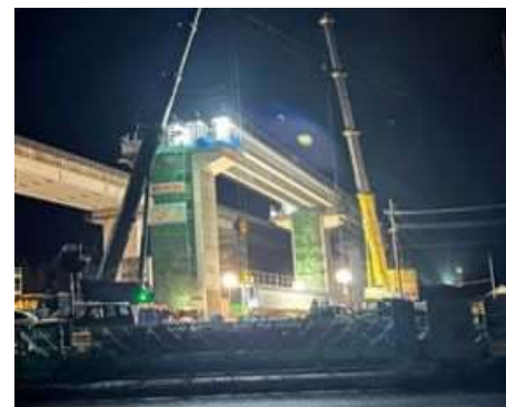
香下大橋上部工架設工事(国道387号側から)
