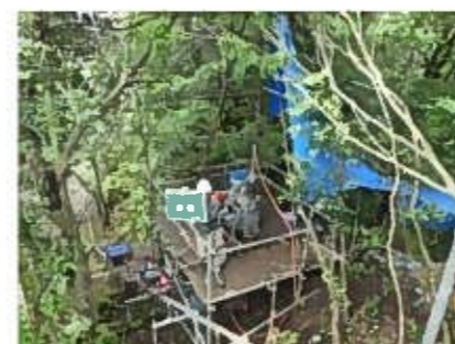
ボーリング調査
