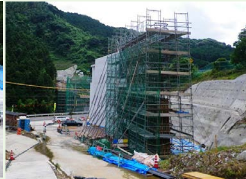
現川橋 橋台2基・橋脚2基 長崎多良見側橋台と橋脚1基が施工完了。 橋台1基、橋脚1基、擁壁を施工中。
