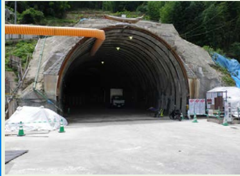
中尾トンネル 延長1,686m トンネルの掘削を開始。 掘進延長約60m（7月末現在）
