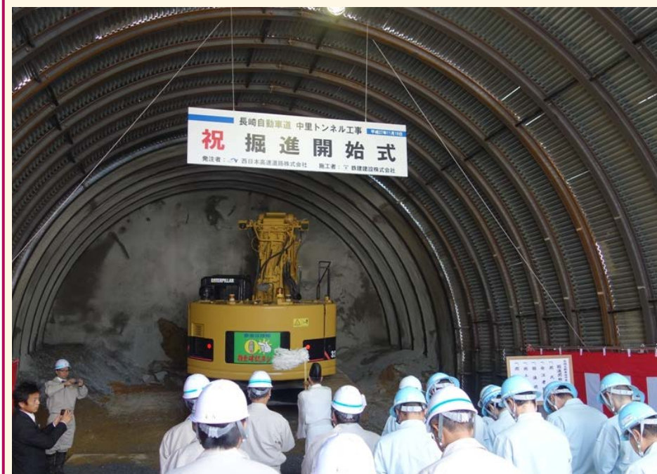
平成27年11月19日、中里トンネル工事の安全祈願・掘削開始式を行いました。
