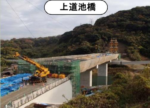
夏に橋桁の架設が終わり、床版のコンクリートも完成してきて、これからは壁高欄などを施工していきます。
