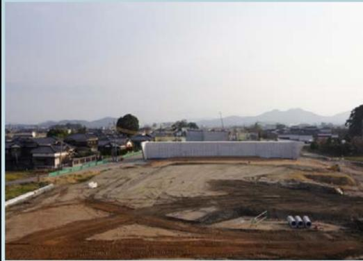
完成したカルバートボックスや橋台の背面側に土を盛り始めました。構造物が完成次第、土を盛る範囲を拡大していきます。
