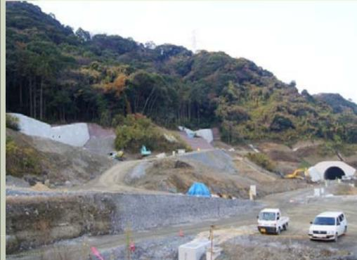
土を盛る作業もほぼ完了しました。現在は、高速道路本線を守るため、土石流対策の堰堤を施工しています。
