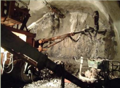
トンネルの掘削もあと少しとなりました。掘削の他にトンネル内側を覆うコンクリートを入り口側から施工しています。
