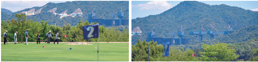
◀グラウンド・ゴルフ場からは、建設中の「信楽川橋(仮称)」が一望できます。新名神高速道路で最も高い橋をご覧ください!
