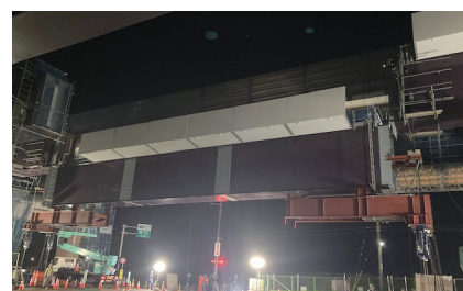
4 ジャッキによる橋桁の吊り上げ
