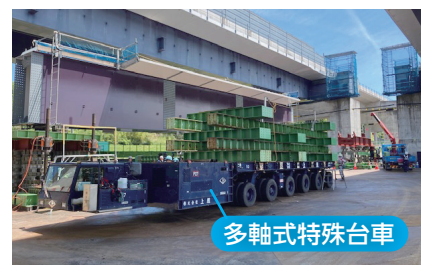
1 橋桁を多軸式台車上に搭載
