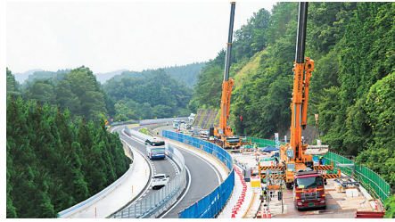
リニューアル工事状況(床版取替)
