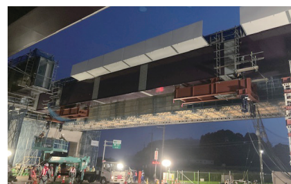
5 吊り上げ完了
