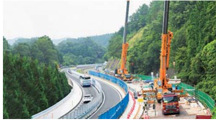
リニューアル工事状況(床版取替)
