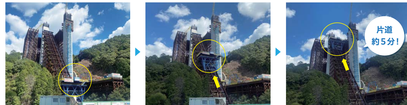
1. 台車へ資機材・重機等を積載
