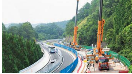
リニューアル工事状況(床版取替)
