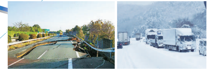
高速道路損傷状況(熊本地震(左)、大雪による立ち往生(右))
