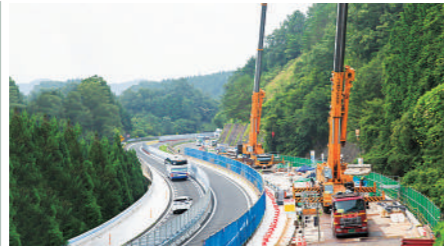
リニューアル工事状況(床版取替)
