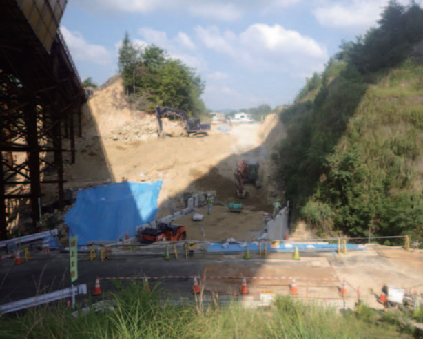
補強土壁施工中
