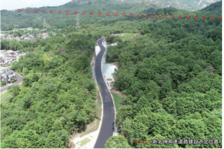
工事用道路完成(8月17日完成)
