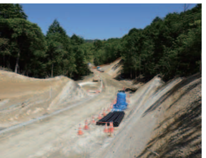
工事用道路施工中(終点方面)
