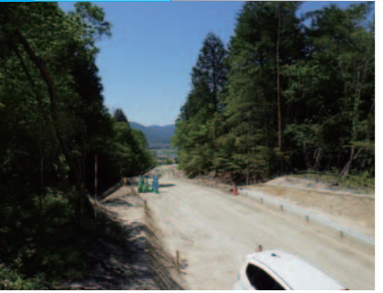
工事用道路施工中(起点方面)
