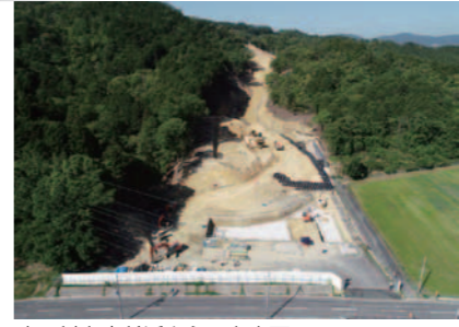
大戸川上空付近から田上方面 場内道路を施工中
