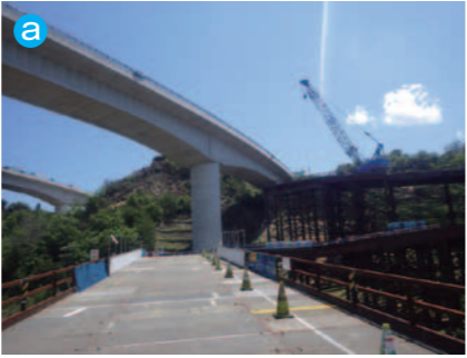
工事用仮橋を施工中
