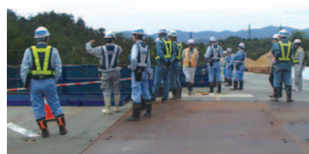
安全パトロールの様子
