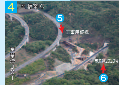
施工状況(航空写真)
