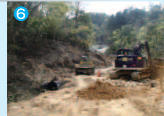
拡幅工事を実施中(市道幹2020号線拡幅)
