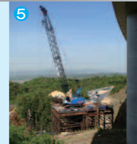
昨年12月から工事用仮橋を施工中(仮橋)
