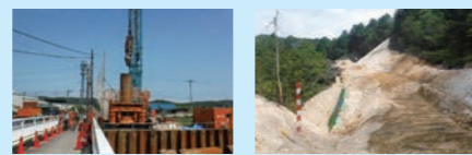
①「荒戸橋」の橋脚の工事を実施中です。 ②工事用進入路の土工を実施中です。
