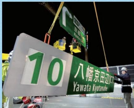
図形を用いた案内標識の中には1辺が10mを超えるものもあり、標識板の重さにあわせて基礎や土台を作り、そこから柱を立ち上げて標識板を設置します。
