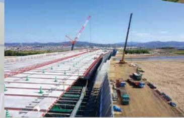
現在第五期目の河川内工事を行っています。上部工の桁架設は完了し、現在、橋梁上の床版や壁高欄などの施工を進めています。
