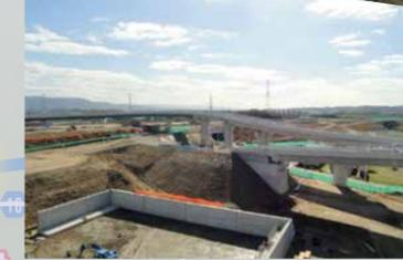
土工工事では、八幡ジャンクション(仮称)からの掘削土を運搬して、盛土造成を進めており、完成した箇所から順次、舗装工事や料金所などの施設工事を行っています。
